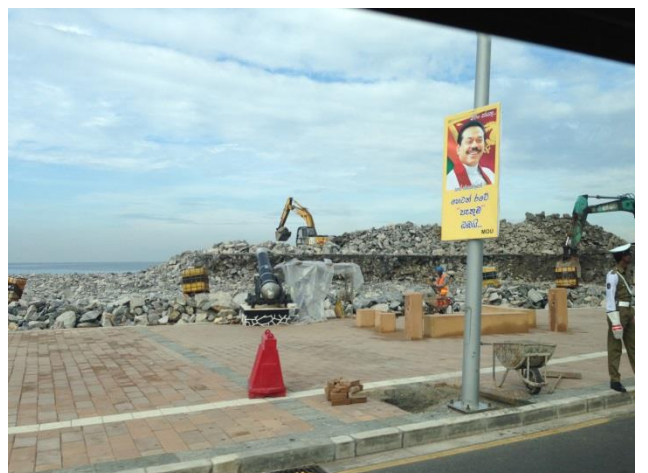
Mellan möten passerar vi Port City bygget. Här har man börjat fylla i havsytta med sten. Fem kvadratkilometer skall täckas de närmaste tre åren.
